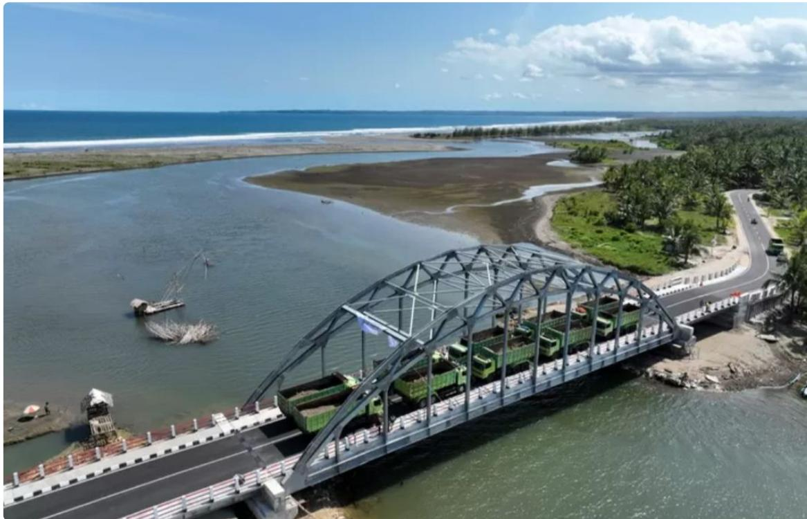
Jamasri mengatakan, tahapan uji beban ini terbagi menjadi 2 metode yaitu secara statis dan dinamis dengan menggunakan kendaraan berat jenis truk tronton yang memiliki bobot masing-masing 25 ton secara bertahap, yang fungsinya adalah untuk mendapatkan hasil yang konsisten dan mengetahui kualitas kekuatan jembatan tersebut.
