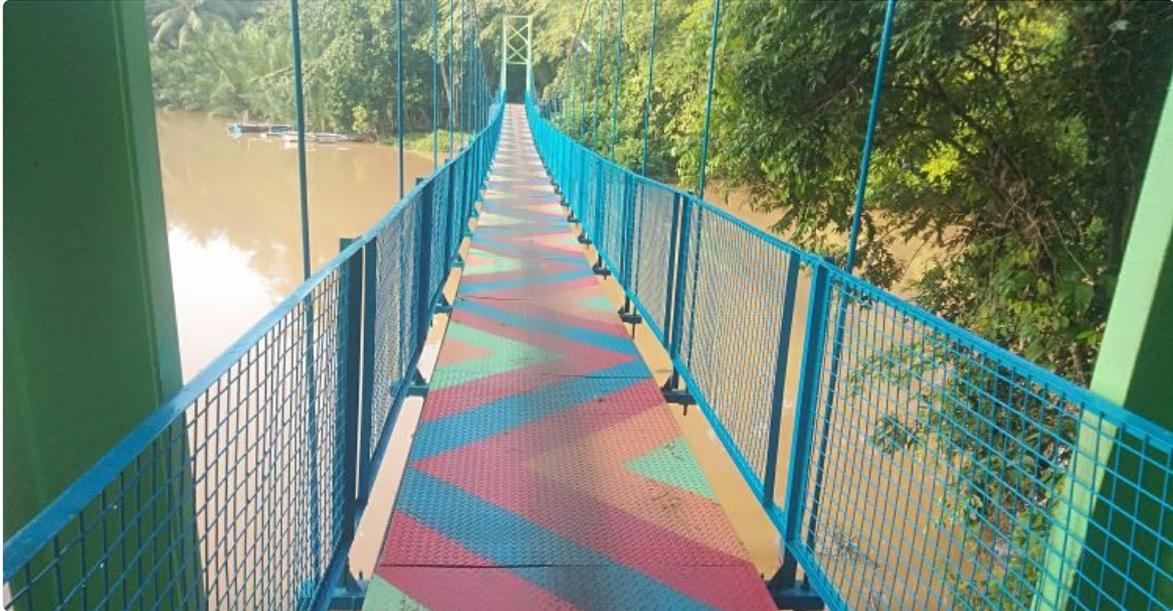
Awalnya Jembatan gantung ini hanya di bangun dengan anyaman bambu, dan kini sudah dibangun kokoh jembatan gantung dengan bahan lantai plat eser, full baja dengan sistem pengerjaan knokdon atau full boud, material berasal dari Swedia, jembatan dengan panjang 60 m dan lebar 1,5 m dengan Cat yang warni warni menghiasi jembatan menjadi indah, dan kini sering di jadikan tempat Selfi oleh kaum milenial yang melintasinya.
